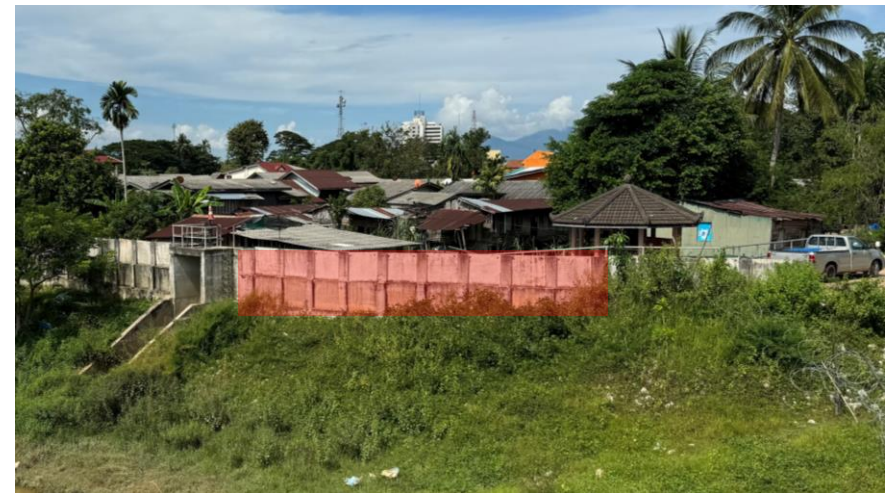
ระบบป้องกันน้ำท่วม
